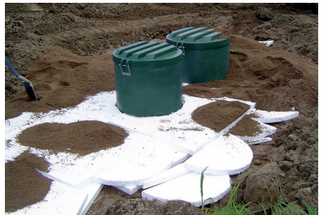
Kuva 12. Säilön eristekerros
