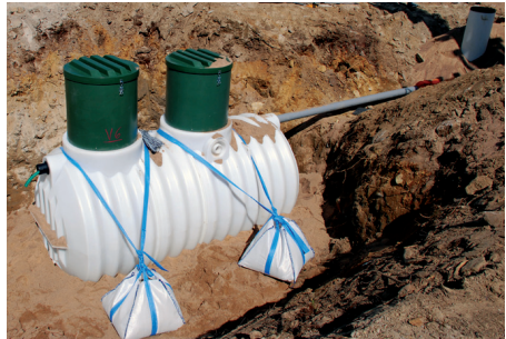
Kuva 9. Säiliön ankkurointi
