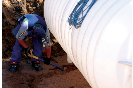
Kuva 8. Säiliön asettaminen kaivantoon
