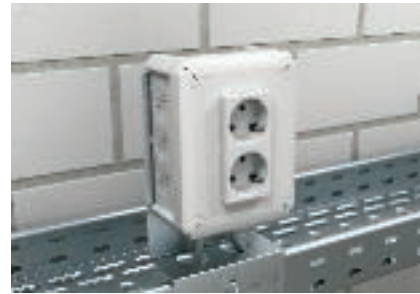
Kiinnitys asennuslevyyn Pohjassa on kahdesta neljään kiinnityskohtaa peltiruuveille 3,5 x 9,5 mm, joista rasia voidaan kiinnittää esim. asennuslevyyn.
