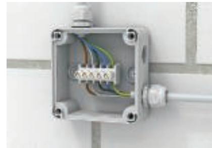
Kytentälaatta Jakorasiaan voidaan asentaa kytentälaatta.
