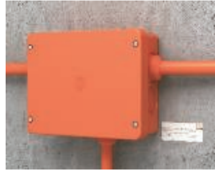
Käyttö: FireBox B 250 E, seinäasennus, haaroitus Valmis asennus, B 250 E merkintäkilvellä.
