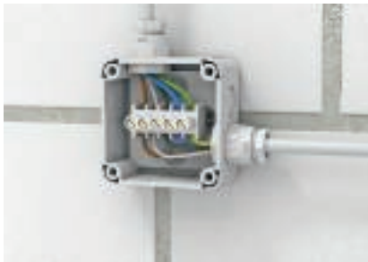
Kytkentälaatta VBX-sarjan jakorasioihin tyyppi VBX KL voidaan asentaa kytkentälaatta.
