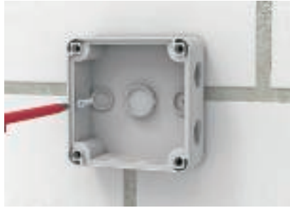
Kiinnitys - B 9/T Pohja-alueella olevissa kiinnitysrei'issä on lävistyskalvo, johon ruuvi kiinnittyy. Se takaa suo- jausluokan.
