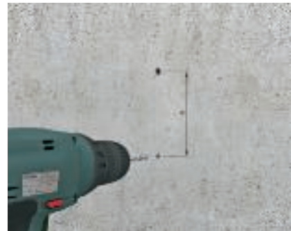
Asennuksen valmistelu Poraus Ø 5 mm väh. 60 mm syvyydeltä, porareikien etäisyys: B 100 E - 88 mm, B 160 E - 105 mm, B 250 E - 113 mm. Porareiät puhdistettava hyvin.
