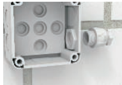
Holkkitiiviste Kalvotiivisteiden sijasta voidaan käyttää myös holkkitiivisteitä. Holkkitiiviste kiinnitetään vastamutterilla aihioon.
