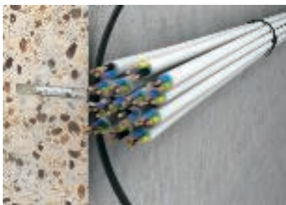
Kaapeleiden kiinnitys Asennettavat kaapelit sidotaan yhteen johdinsiteellä.
