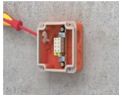
Asennuksen valmistelu Läpivientiaihiot murretaan.
