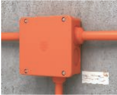
Käyttö: FireBox B 160 E, seinäasennus, haaroitus Valmis asennus, B 160 E merkintäkilvellä.
