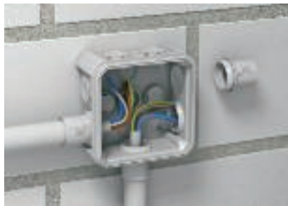
Putkinyvät Asennusputkien asennusta varten on saatavana myös putkinyviä. Niiden avulla voidaan tehdä tiivis asennus.
