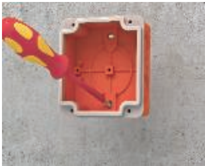
Asennuksen valmistelu Aukkojen murtaminen pohjaan.
