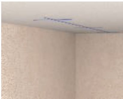
Asennuksen valmistelu Porareikien tarkan sijainnin merkintä kaapelikiinnikkeitä varten merkintälangalla.
