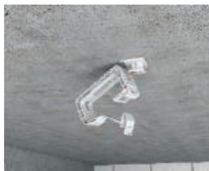
Kaapelikiinnikkeen kiinnitys Kiinnitysosa irrotetaan Grip-kaapelikiinnikkeestä veto-kääntöliikkeellä.
