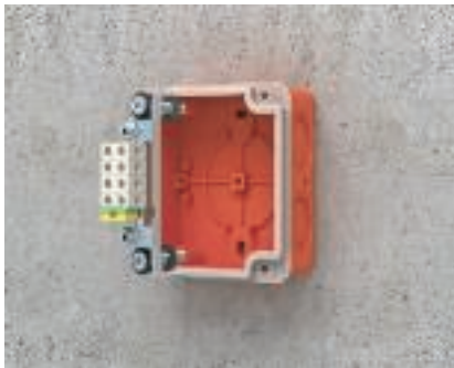
Jakorasian kiinnitys Rasia kiinnitetään kytkentälaattoineen.
