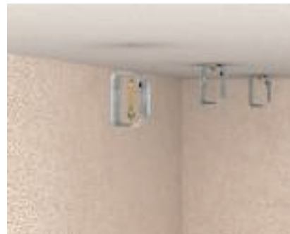
Kaapelikiinnikkeiden asennus kattoon Avattavien kaapelikiinnikkeiden asennus kiila-ankkureilla.
