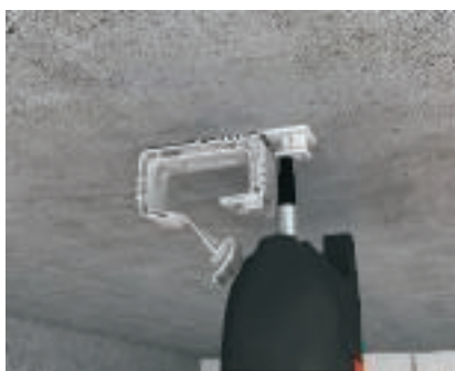
Asennus kattoon kaasunaulaimella Kaapelikiinnikkeen kiinnitysosa voidaan asettaa kaasunaulaimen päähän ja se lukkiutuu lamellien avulla automaattisesti alasaan. Seinä- ja kattokiinnitykseen ei tarvita kaasunaulaimen lisäksi muita apuvälineitä.
