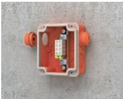
Asennuksen valmistelu Kalvotiivisteiden asennus.
