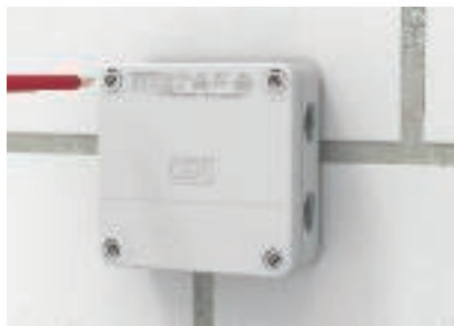
Kannen asennus Ruuvit ruuvataan kiinni ruuvitaltalla.
