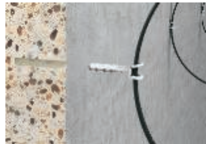
Käyttö: 910/STK Porataan reiät ja viedään johdinside kiinnitystulpan kaaren lävitse.
