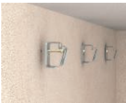
Kaapelikiinnikkeiden asennus seinään Kaapelikiinnikkeet kiinnitetään seinään kiila-ankkureilla tai ruuvitulpilla ja ruuveilla.
