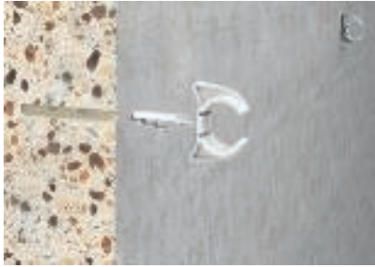
Käyttö: Snap-kiinnike Kiinnitysreiän merkintä.
