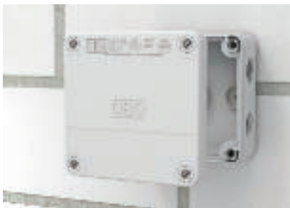
Kannen asennus Kansi kiinnitetään rasiassa.
