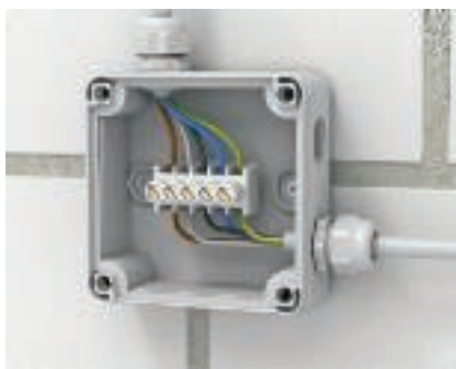
Kytkentälaatta Jakorasiaan voidaan asentaa kytkentälaatta.
