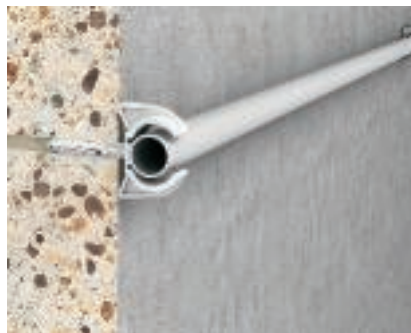
Snap-kiinnikkeen asennus Kiinnike esikiinnitetään porareikään kiinnitystulpalla. Aseta asennusputki kiinnikkeeseen ja paina kiinnikettä putkella asennuspintaan.
