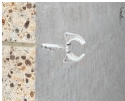
Käyttö: Snap-kiinnike Kiinnitysreiän merkintä.
