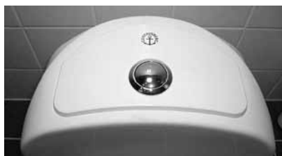
2300 sarja, 2002– Kega 6 l, korvataan Twico II 6 l adapteri + venttiili + painonappi
