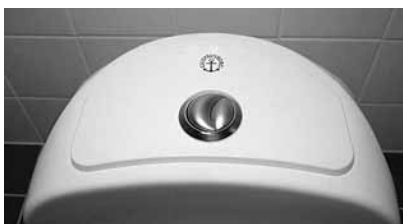
Twico I Duo, korvataan Twico II venttiili + painonappi
