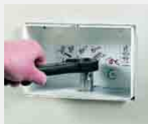
↑ Korkeutta voidaan säätää säätöpultista, mikä on helposti käytettävissä huuhtelupainikkeen takana.
