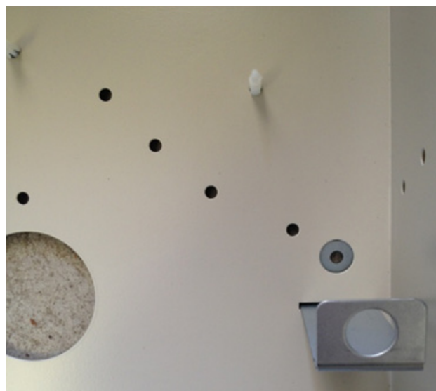
Kuva 2. Kansisuojan kannatinraudan asennus.
