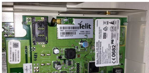
Kuva 8. Asennuskehikon asettaminen keskuskoteloon.
