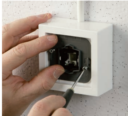
IMPRESSIVO®-kytkimet ja -painikkeet saadaan asennettua roiskevesitiiviiksi pintakojerasiaan, kun huomioidaan johtimien taivutus rasian sisällä ja käytetään ruuvikiinnitteistä vipurunkoa. Myös kolmevipuinen kytkin on näin asennettuna roiskevesitiivis.
