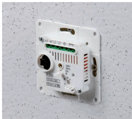
Uusien termostaattien keskiölevy on kiinnitetty ruuvilla, joka löytyy säätökiekon alta. Keskiölevyn alta löytyvät myös termostaattien asetussäädöt: lattian lämpötilan rajoitus sekä lämpötilan pudotus, joka on myös lattiatermostaatissa vakiona.
