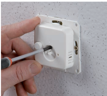
Uusien termostaattien keskiölevy on kiinnitetty ruuvilla, joka löytyy säätökiekon alta. Keskiölevyn alta löytyvät myös termostaattien asetussäädöt: lattian lämpötilan rajoitus sekä lämpötilan pudotus, joka on myös lattiatermostaatissa vakiona.
